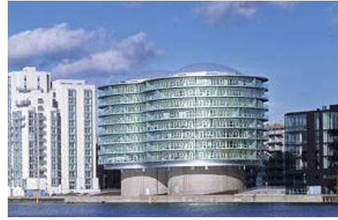
Silo réhabilité habillé de logement (Copenhague)
